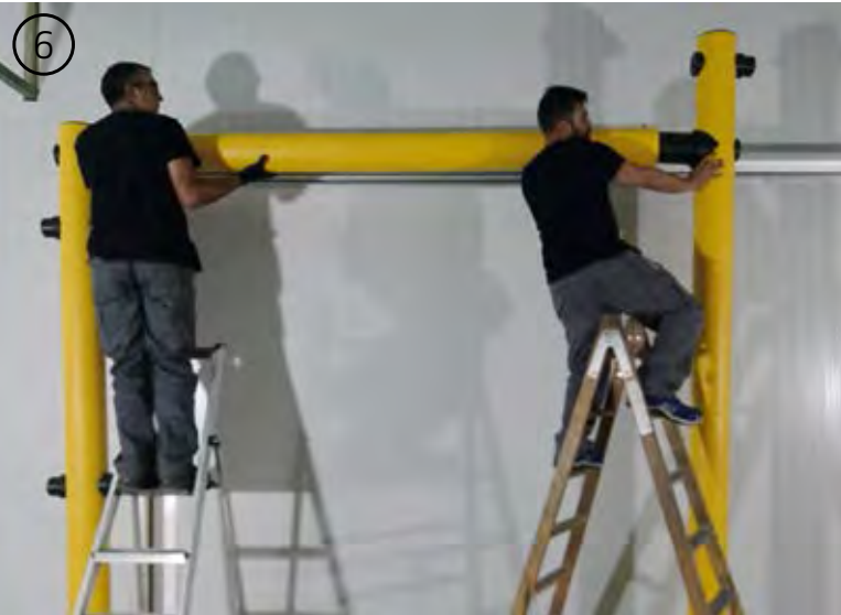
Introducir dintel Crossbar placement
