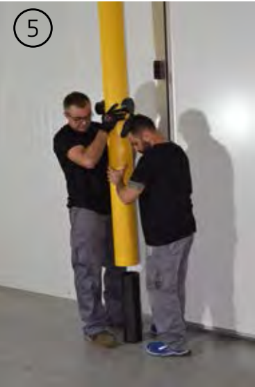
Introducir jamba Post placement
