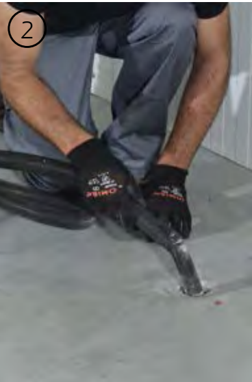
Aspiración y limpieza Aspiration and cleaning
