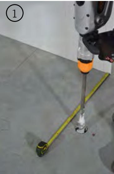
Medición y perforado Measuring and drilling
